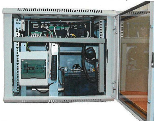
Рисунок А.4.10 – Комплекс громкоговорящего оповещения ИТК ОС КГО (на базе УКБ «ГРОМ»)
